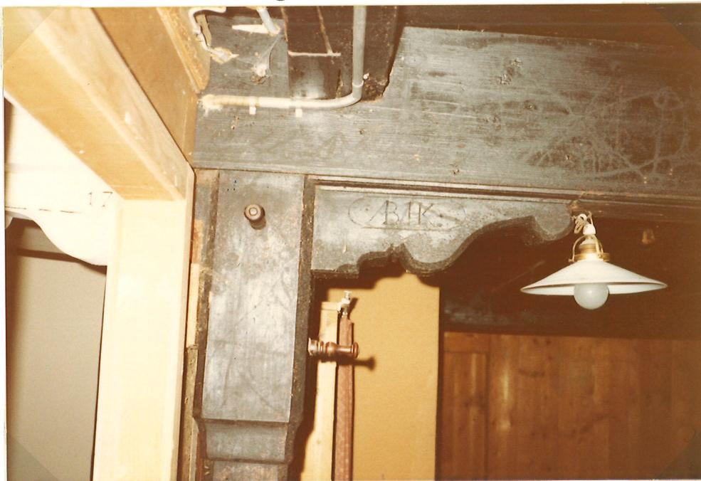
Der 2. Stock befindet sich im Ständerbau. In der Mitte des Raumes auf der Skizze und auf dem Photo (4) steht ein kräftiger profiliertes schwarzer Pfeiler. Zwischen diesem und der Decke befindet sich ein Sattel mit der Inschrift "1702 AB HK".
